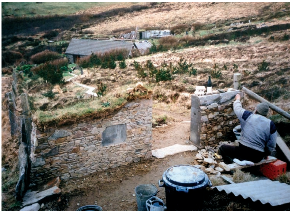
Reiners Naturstein-Verkleidung am Eingang zum erweiterten Grundstück (1996)
