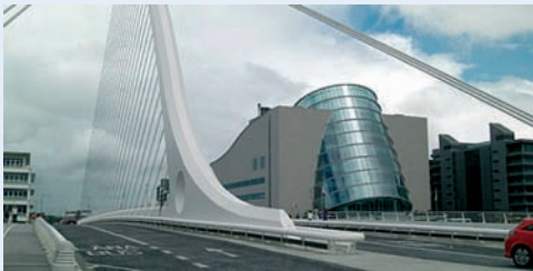
Die Beckettbrücke in Dublin erinnert an den Bau-boom früherer Zeiten.
