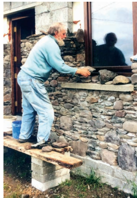
Reiner verkleidet eine Fassade mit Naturstein (1997)
