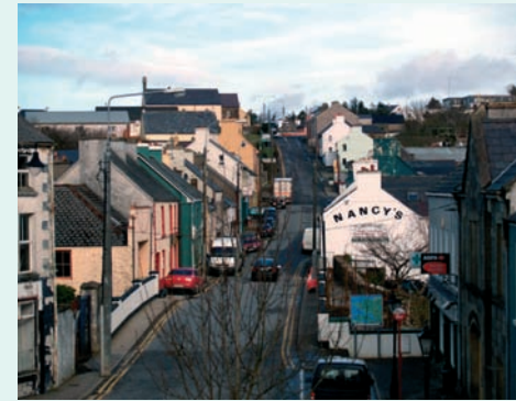
Die Hauptstraße in Ardara
